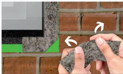
5. Das überstehende Dichtband mit Vlies stretchen und vorne an das Mauerwerk kleben, um mögliche Kanäle im Eckbereich sicher zu verschließen.
